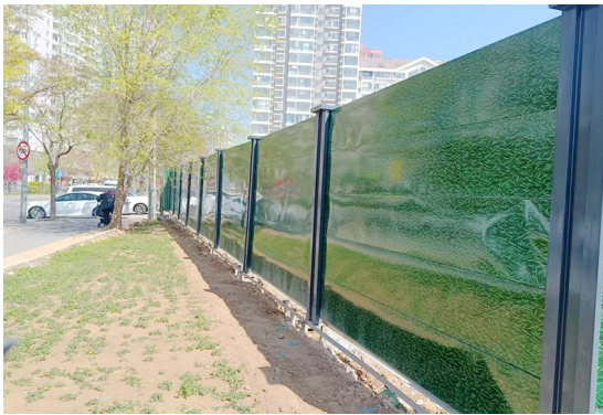
项目北侧围挡
