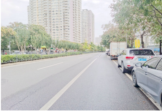
项目西侧现状道路
