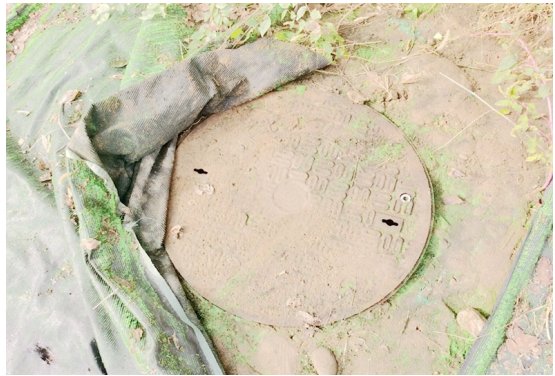
项目内通讯检修井
