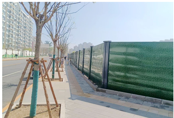
项目西侧围挡
